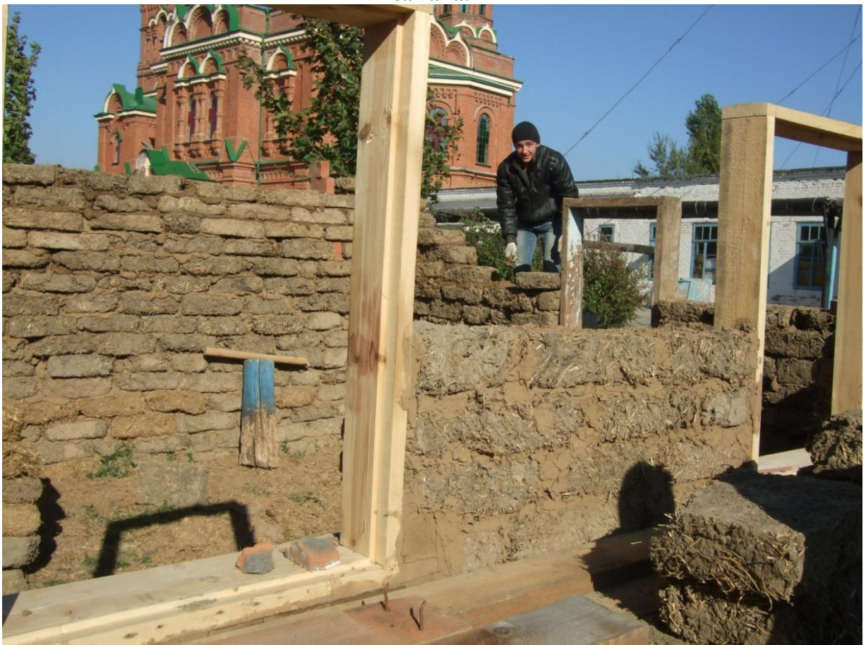
Чехов Владислав работает на возведении стены.
