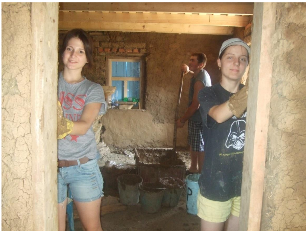
Нима Петрова и Юля Ляховец мажут стены. Раствор мешает Володя Буров.
