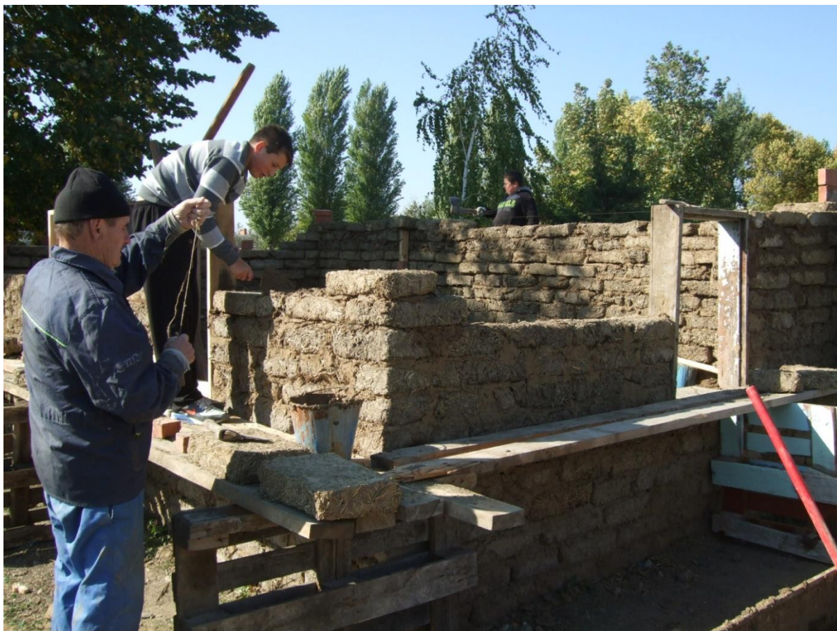
Виктор Михайлович Соболенко отвесом проверяет, ровно ли ребята кладут стену.
