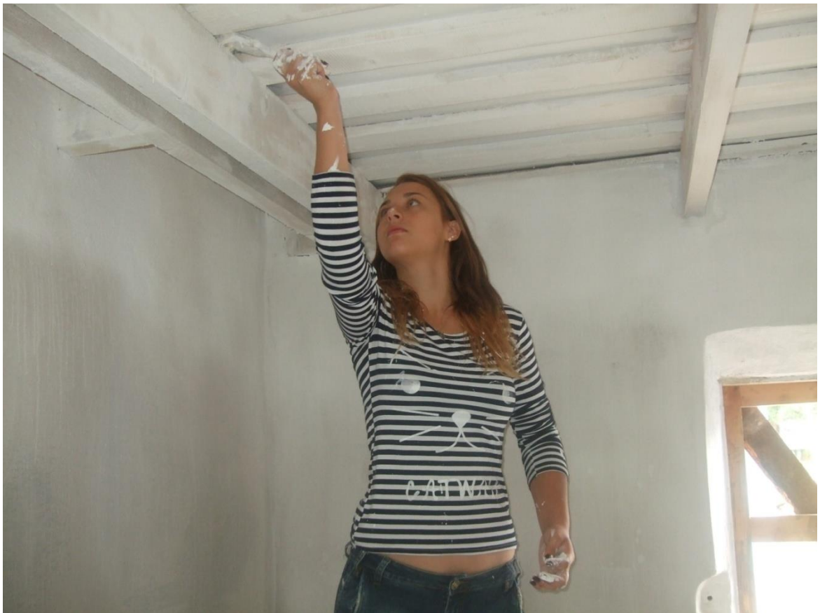
Диана Кочеткова выполняет первую и вторую побелку стен и потолка.
