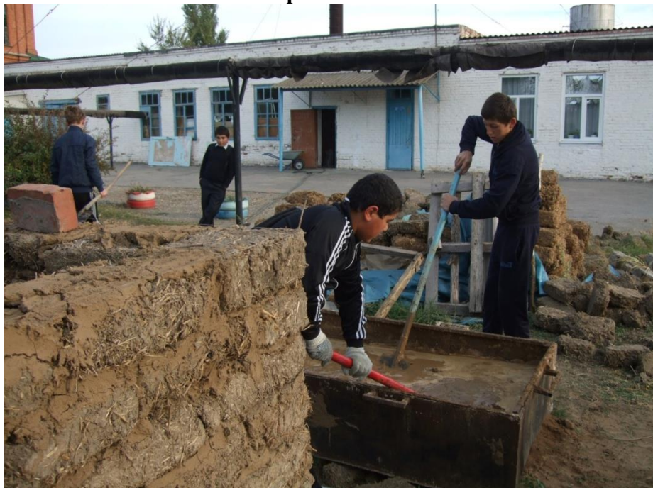
И закипела работа. Алексеев Виктор, Гасанов Сархат замешивают раствор.
