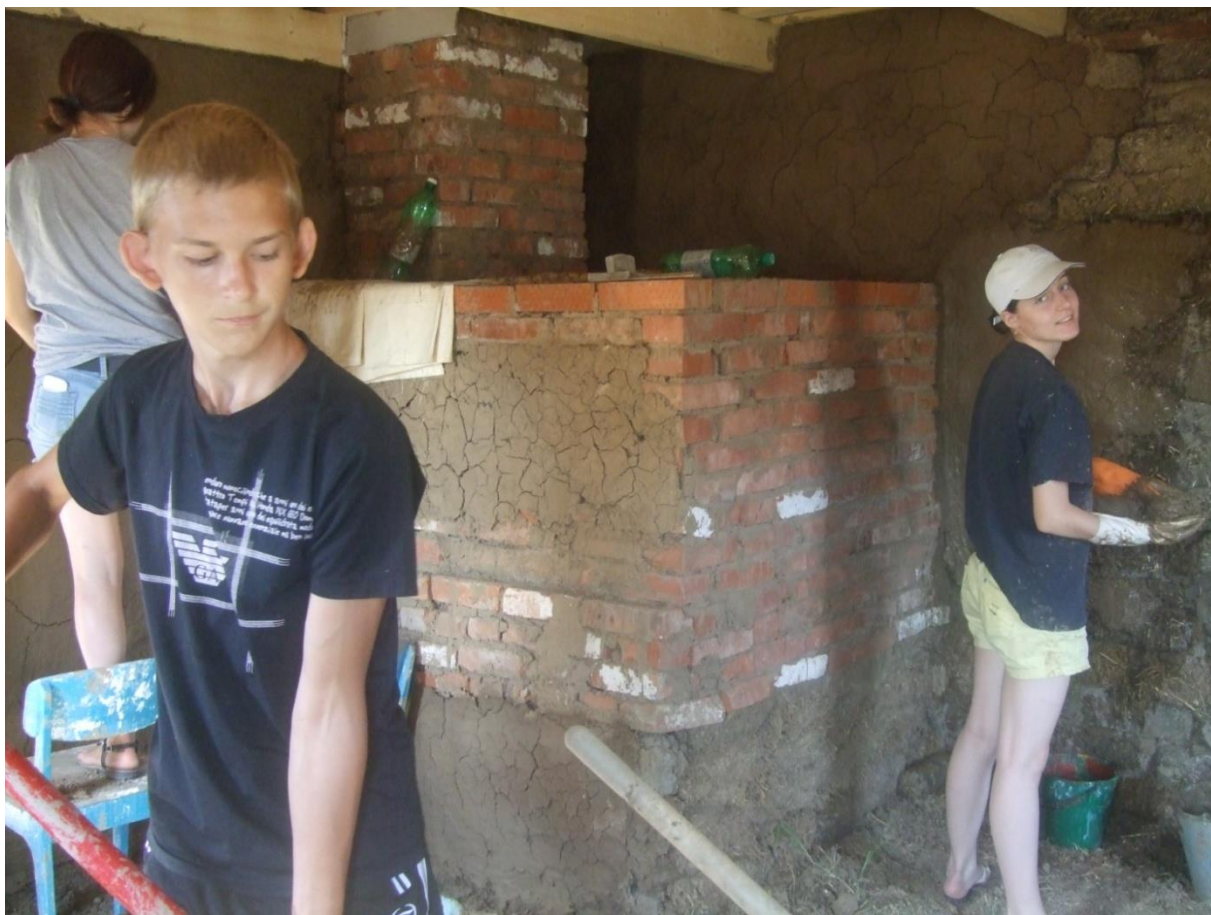
Поляков Никита накладывает в ведра раствор. Нима Петрова и Юля Ляховец мажут стены.
