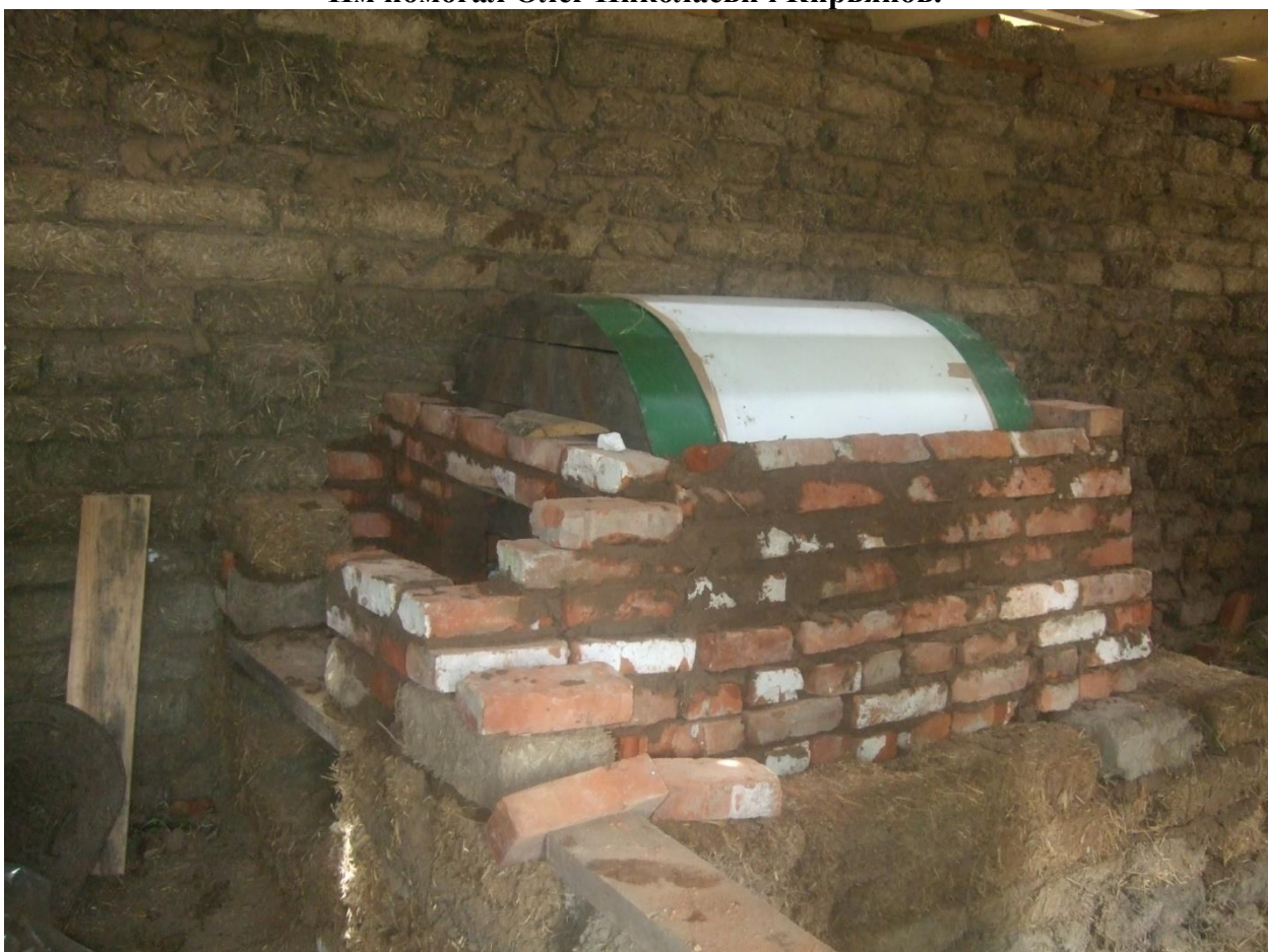
Строили печь по всем правилам: вставили кабана, а затем его обложили кирпичом.
