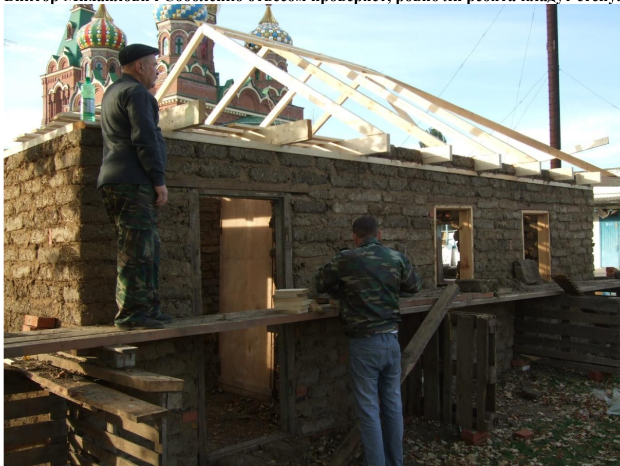
Когда стены были выложены, казаки приступили к возведению крыши. Александр Павлович Будко и Эдуард Анатольевич Фарафонов устанавливают стропила.
