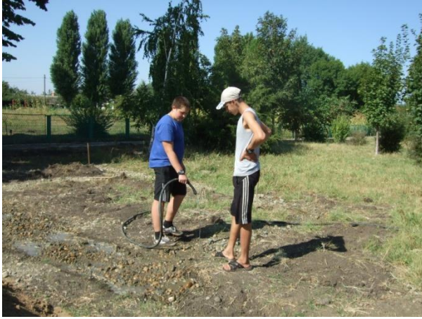
Засыпали траншеи гравием, Буров Владимир и Гороховатский Евгений пролили водой. Утрамбовали. Гороховатский Евгений утрамбовывает гравий.
