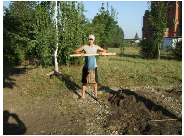
Засыпали траншеи гравием, Буров Владимир и Гороховатский Евгений пролили водой. Утрамбовали. Гороховатский Евгений утрамбовывает гравий.
